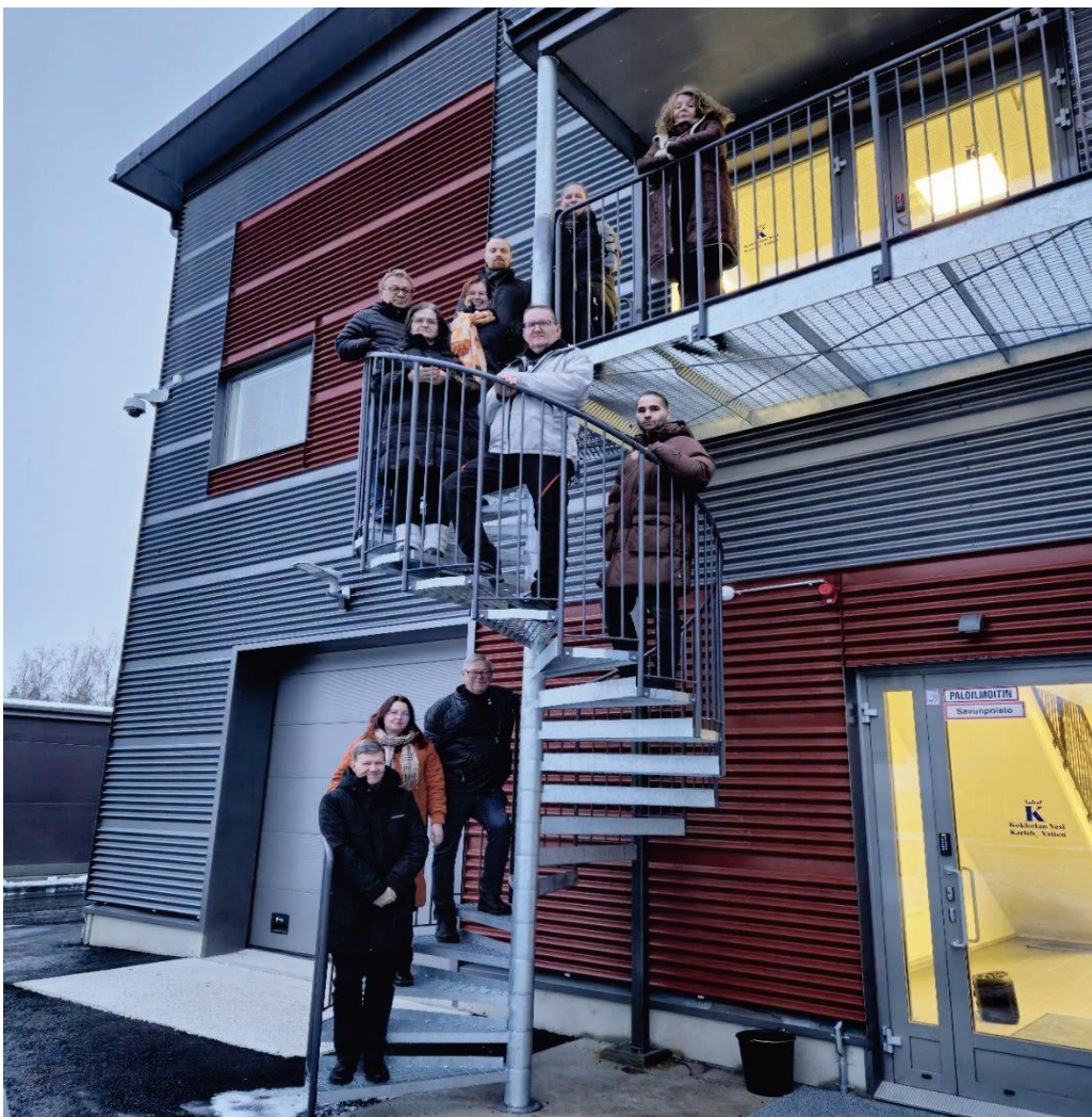
Kuva. Johtokunta tutustumassa Patamäen uuteen vedenkäsittelylaitokseen.
