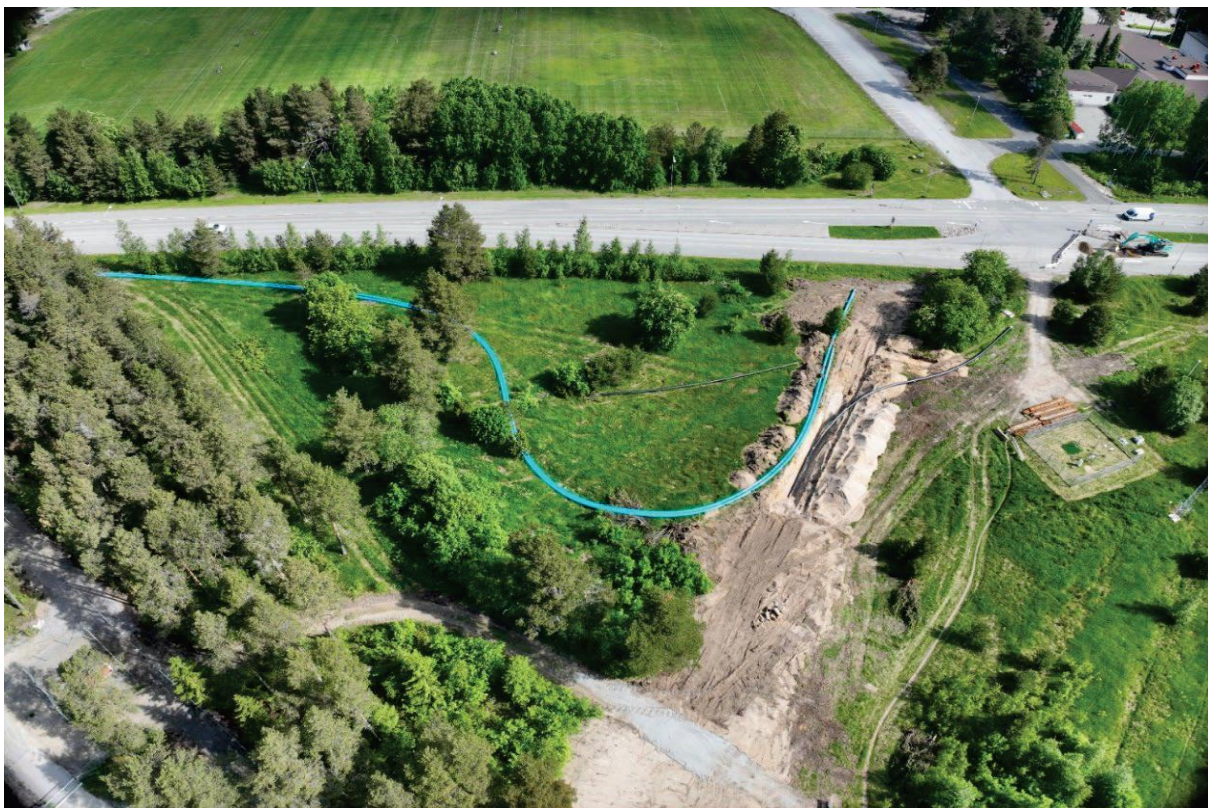
Kuva. Tehtaankadun vesijohdon saneeraus.
