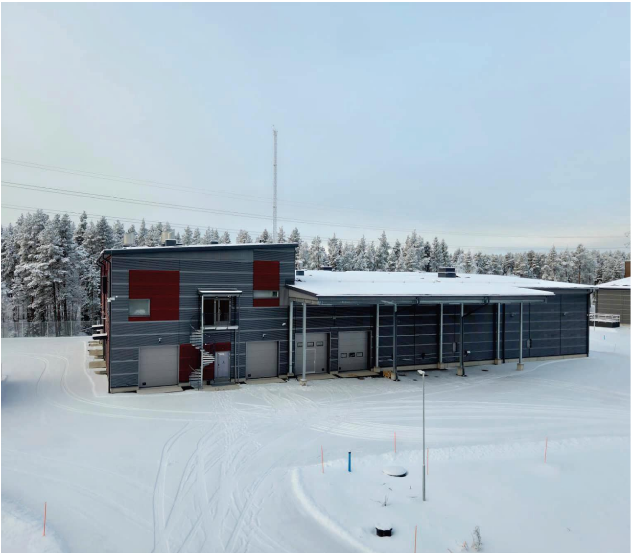
Kuva. Patamäen uusi vedenkäsittelylaitos
