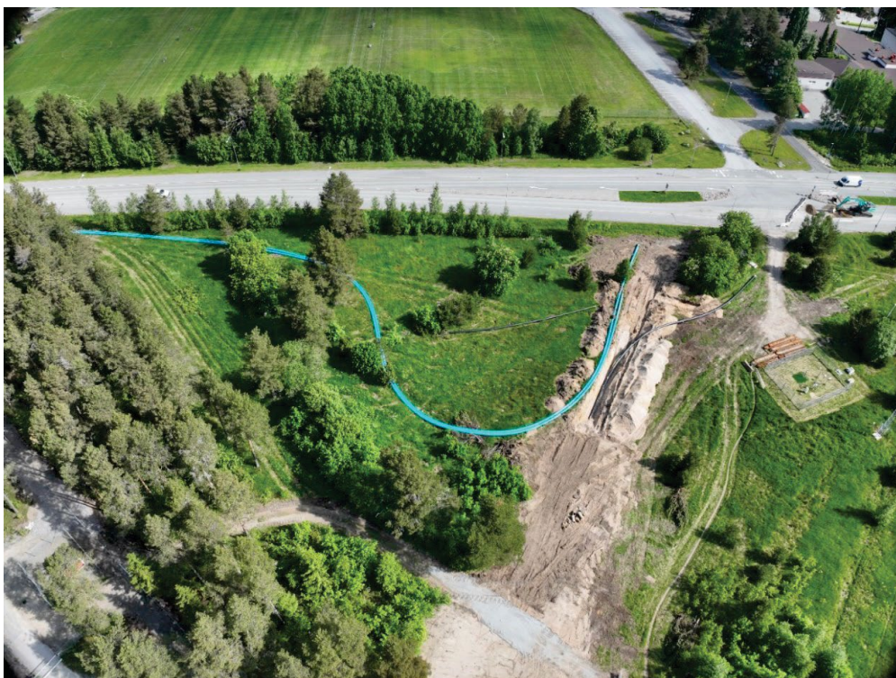
Bild. Sanering av vattenledningen vid Fabriksgatan.
