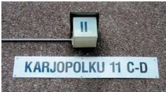
Kuva 4. Rakennuksen osoitumerkintä kadunnimi ja -numero -mallin mukaisesti (niminumerokilpi).
